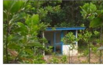
Kawasan Yang Sepatut Dipajak Kepada Lamberts - Rumah Pam Air Yang Belum Digunakan (08.03.2011)
